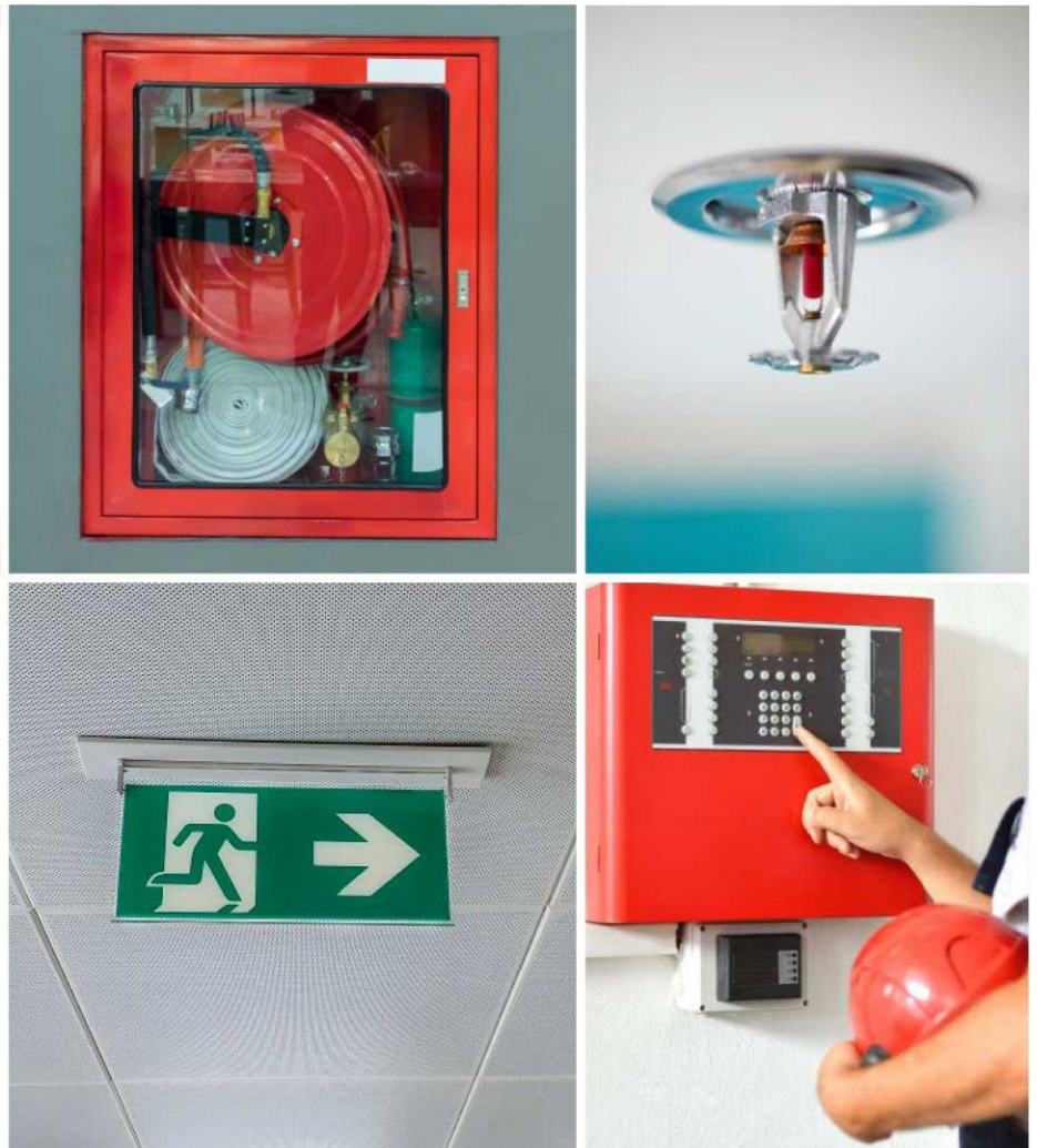
Obr. 3.1 Príklady protipožiarneho a bezpečnostných prvkov a označenia (v smere hodinových ručičiek od horného ľavého rohu): Označenie zhromaždiska, hasiaci prístroj v skrini s protipožiarou hadicou, automatický protipožiarne sprinkler, ovládací panel požiarneho poplachu, označenie východu, hlásič požiarneho poplachu
